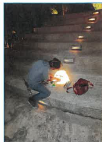
ภาพถ่ายที่ 2.2-27 การบำรุงรักษาหลอดไฟฟาส่องสว่าง
