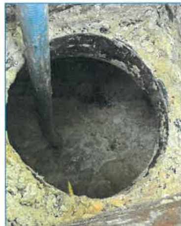
ภาพถ่ายที่ 2.2-17 การดูดกากตะกอนจากระบบบำบัดน้ำเสีย
