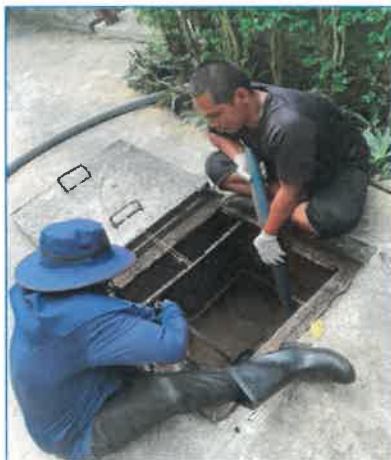
ภาพถ่ายที่ 2.2-17 การดูดกากตะกอนจากระบบบำบัดน้ำเสีย
