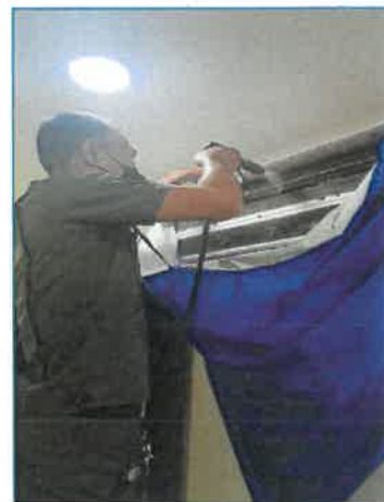
ภาพถ่ายที่ 2.2-31 การทำความสะอาดระบบปรับอากาศและระบบระบายอากาศ
